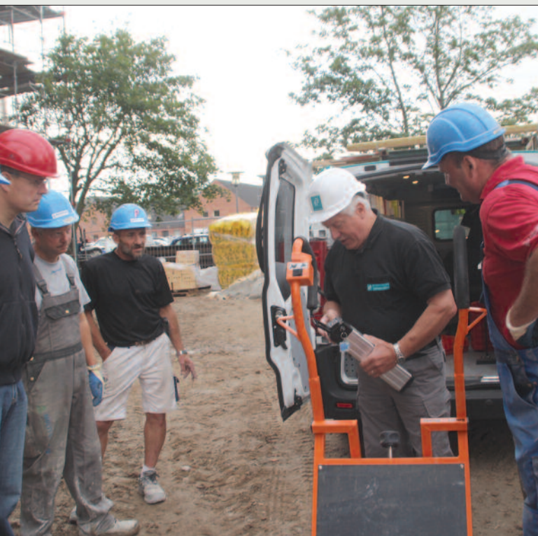
Batteriet monteres, så er vi klar til at køre, og batteriet skulle kunne holde hele dagen og lades op om natten.
